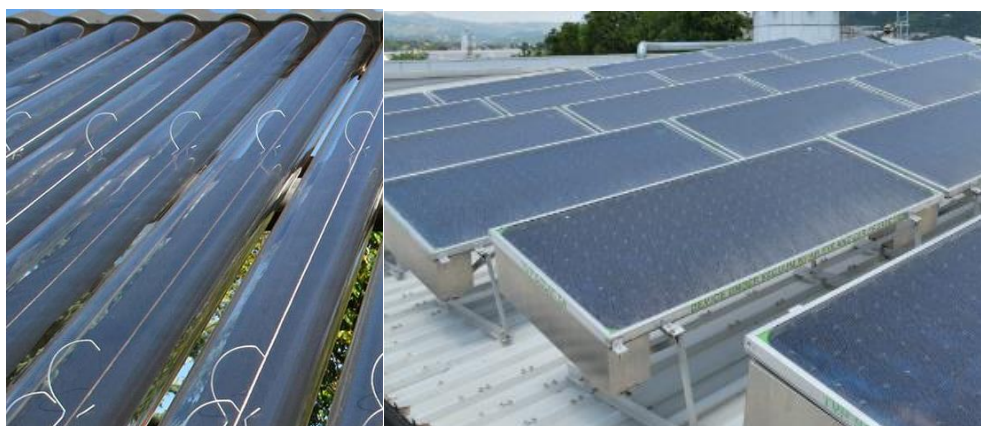
Figuur 10. Links, vacuüm tube paneel, rechts, flat panel collector
